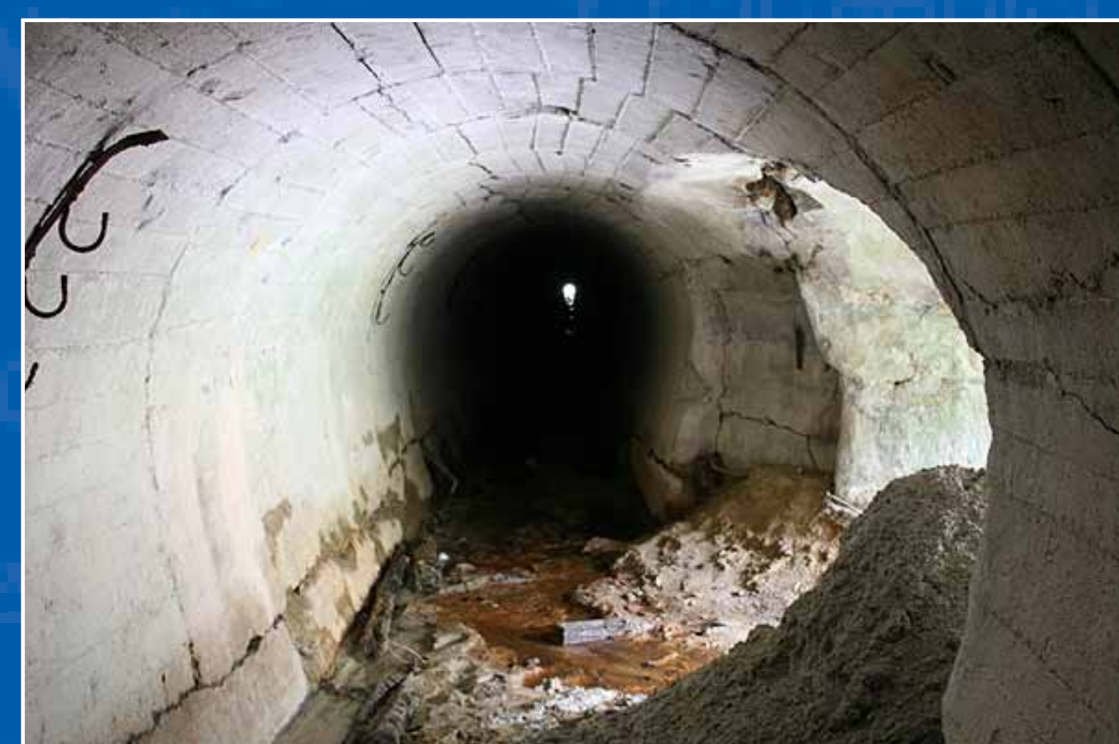
Tunel úzkolejné vlečky ze šamotárny do kaolínového lomu.
