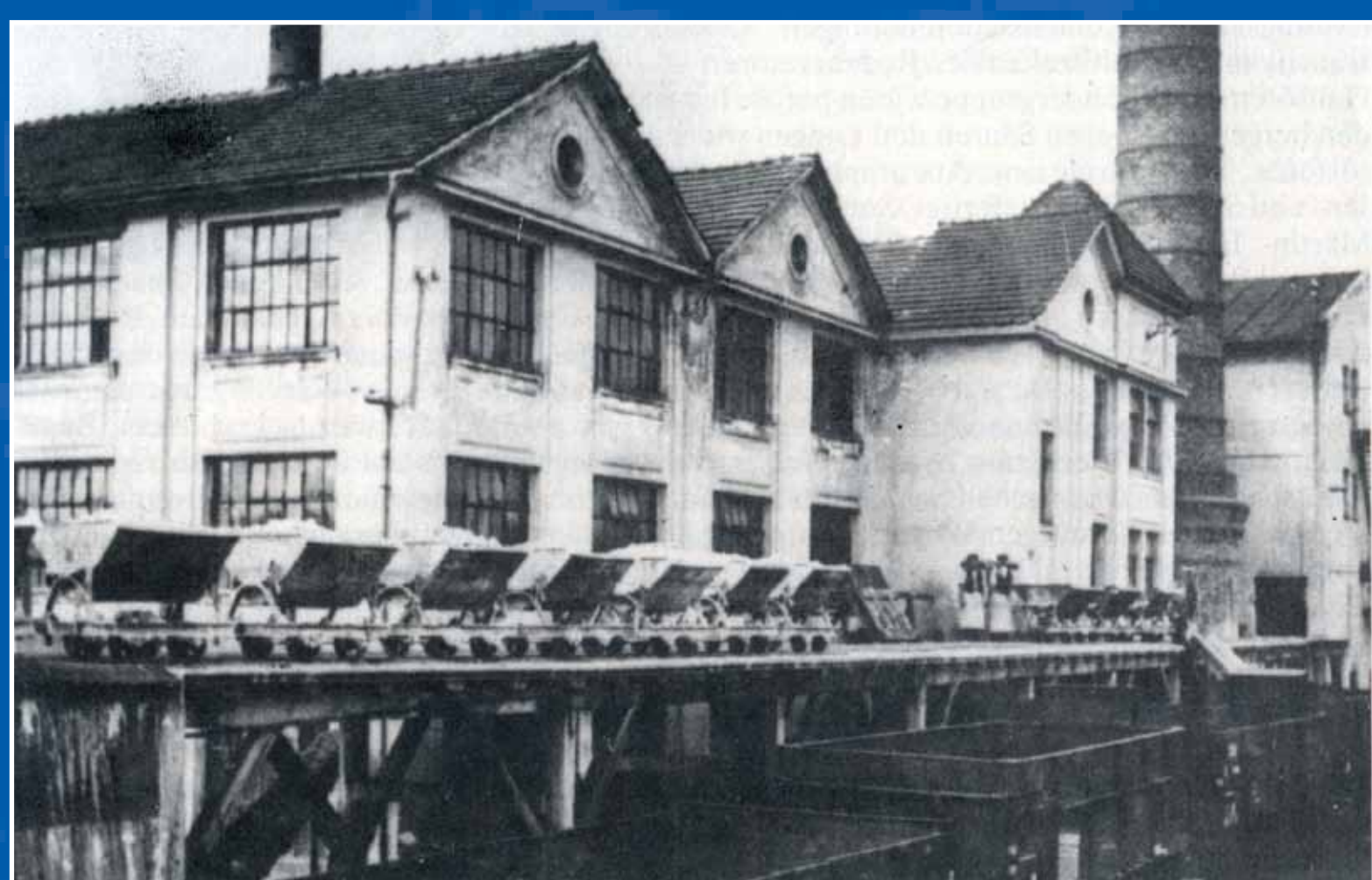
Setkání tratí - nahoře úzkolejka s vozičky kaolínu, dole standardní železniční vozy.
