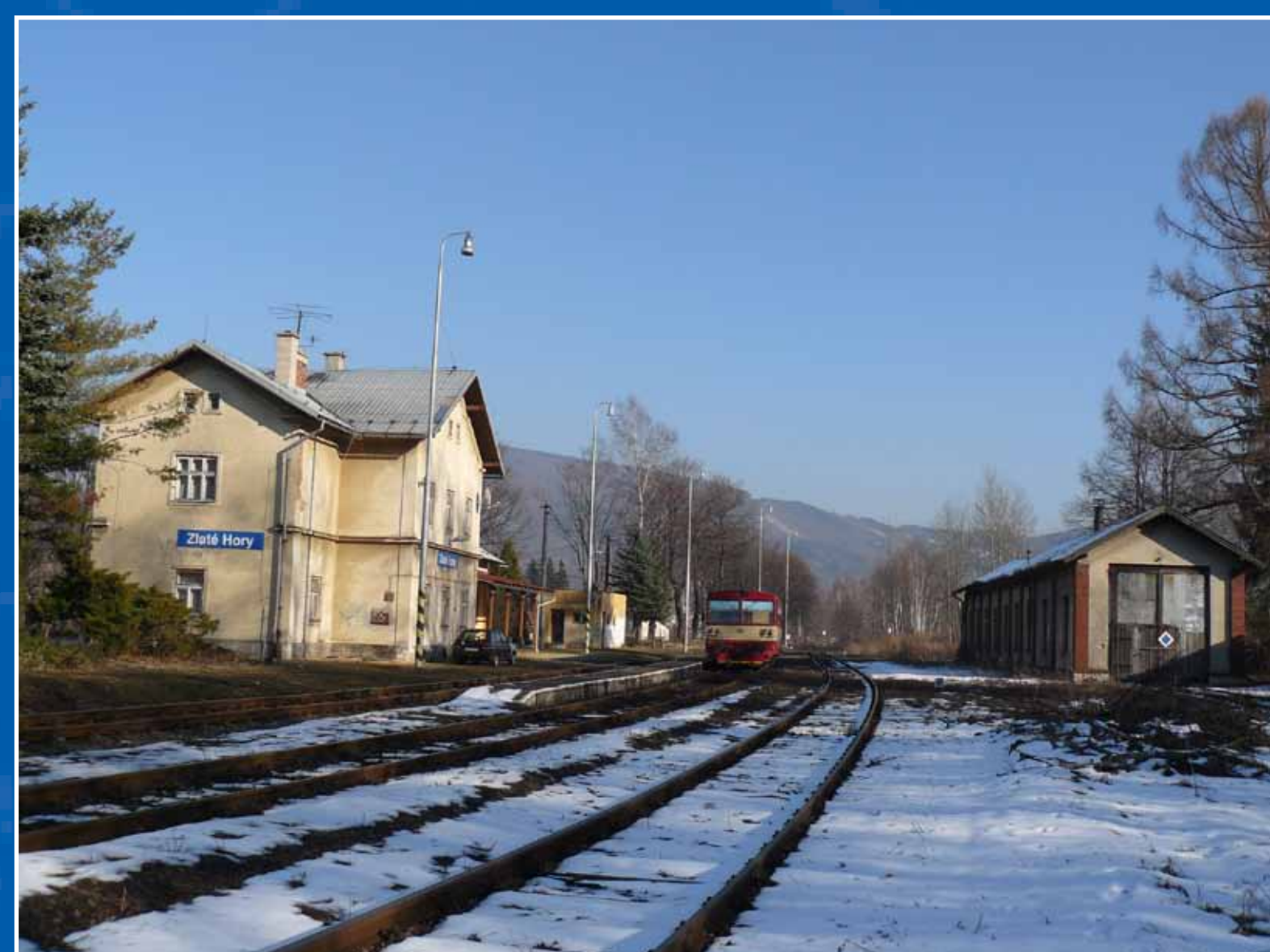
Nádraží Zlaté Hory - vlevo nádražní budova, vpravo bývalá výtopna.
