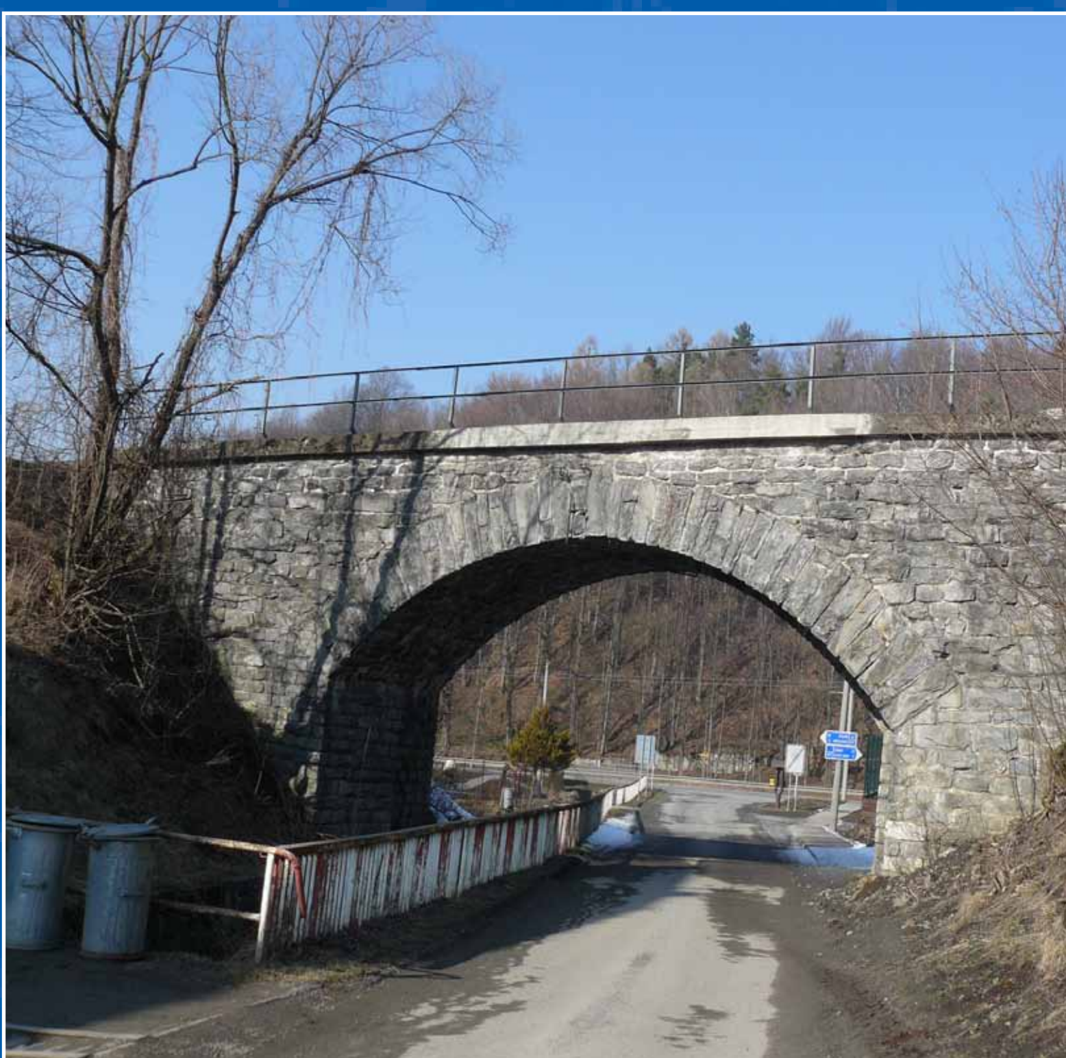
Kamenný viadukt v Ondřejovicích.
